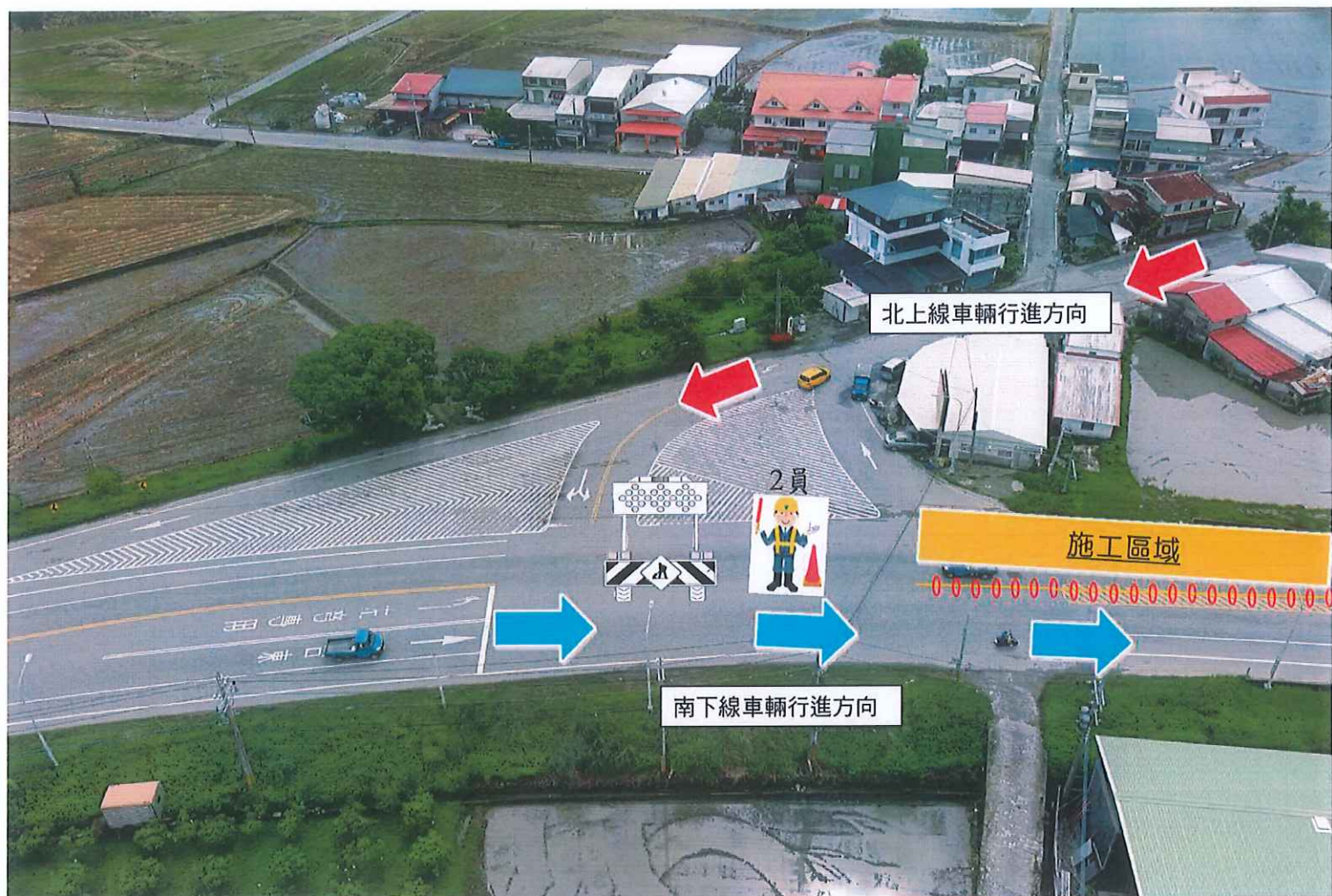
圖1_樂合溪橋北端調撥車道情況1
